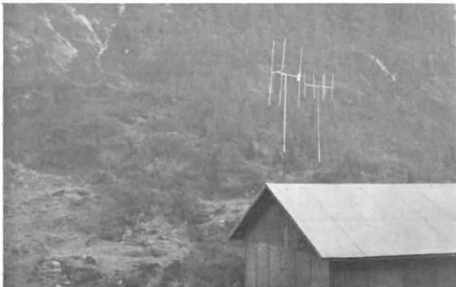
Antenne di radiotelefonii su 72 e 165 MHz in una baracca rifugio di alta montagna (foto dell'Autore)
