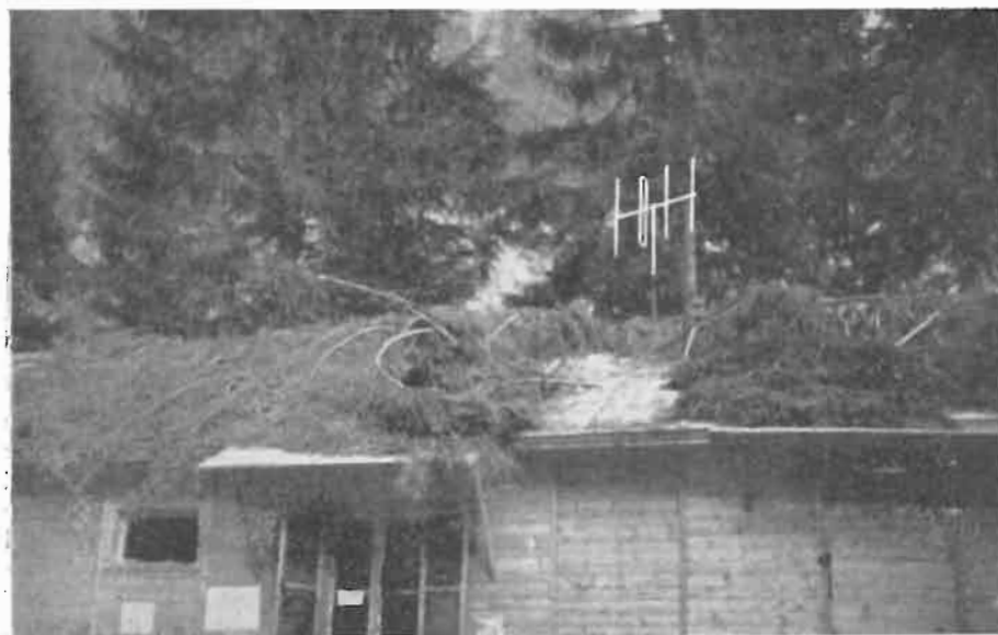
Antenna sperimentale di un ponte radio installato in Valle del Chiese (Trentino) (foto dell'Autore)
